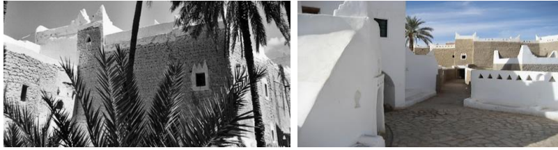
شكل(6).شكل الفتحات(قلة الفتحات في الواجهة)
