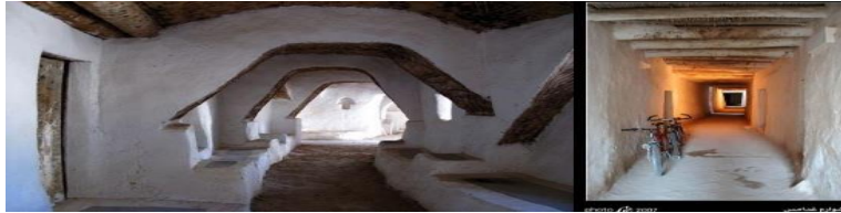
شكل(7): شكل الحوائط داخل مدينة غدامس المصدر: ( Albarssi,Farkash )
